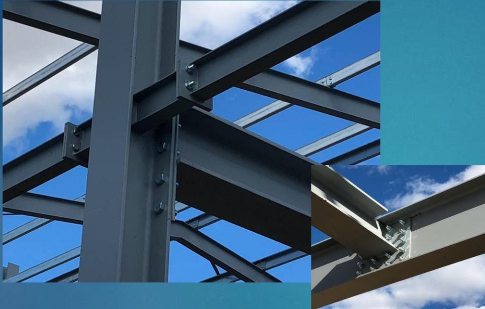
Transformamos tu estructura tradicional a atornillada, te damos la opción de galvanizar, te damos la posibilidad de desmontajes para incorporación de equipos y sobre todo garantizamos con ello la mayor rapidez de montaje.
